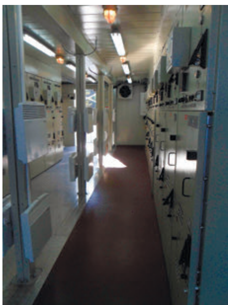
Система освещения и обогрева
