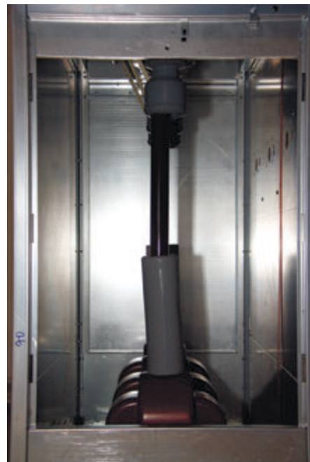
Измерительная ячейка ТН, 750 мм
