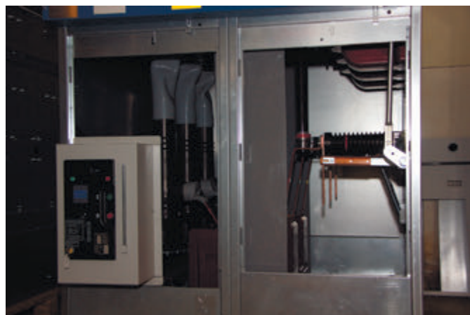
Установка ТН до ввода, 1500 мм
