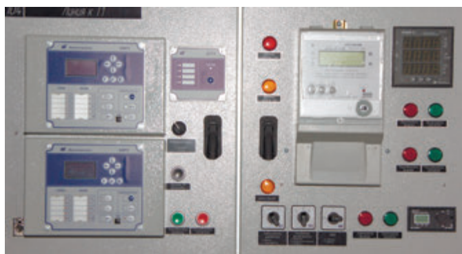
Сигнальные лампы на двери отсека вспомогательных цепей
