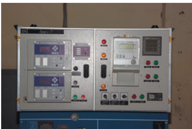
Отсек вспомогательных цепей шириной 1000 мм
