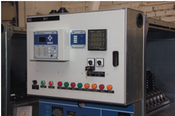
Отсек вспомогательных цепей шириной 750 мм
