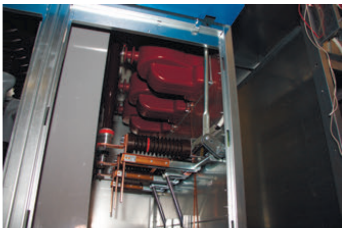
Установка ТН до ввода, 1500 мм
