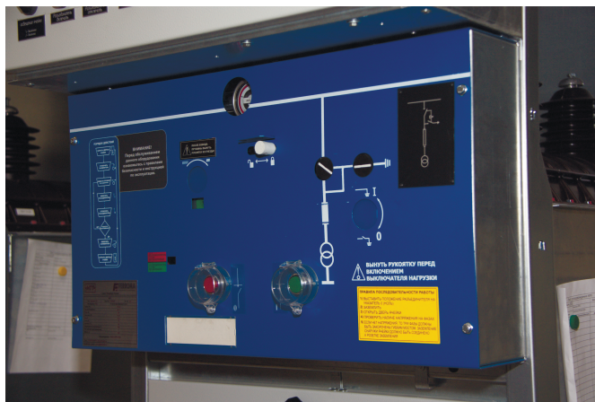
Закрывающаяся панель отсека привода
