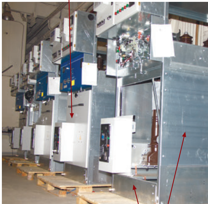
Корпус из оцинкованной стали
